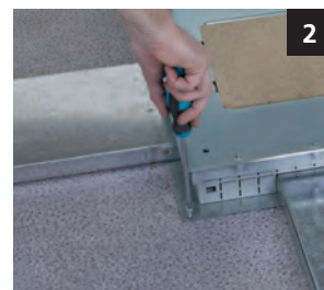
2 Introducir las canales y atornillar al suelo
