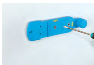
2 Fijar la plantilla en el primer agujero y marcar con un destornillador o la broca el resto de agujeros a realizar en la pared.
