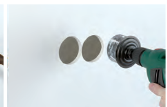
3 Apartar la plantilla y realizar el resto de agujeros en los puntos marcados.
