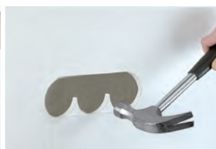
5 Romper los tabiques intermedios de yeso con un martillo.
