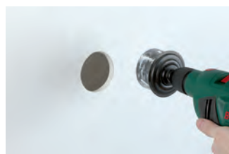
1 Agujerear la pared hueca con una broca. Utilizar corona de Ø 68 mm.
