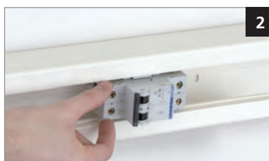
2 Clipar el conjunto al perfil o al canal perimetral.
