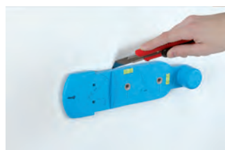
4 Marcar con un serrucho o cuchilla el borde de la plantilla.
