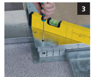
3 Nivelar con los tornillos
